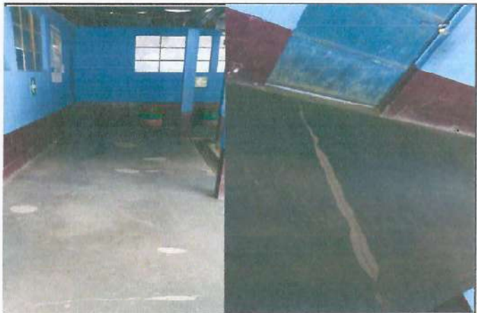
Foto 4: Piso del corredor del Módulo 1.
